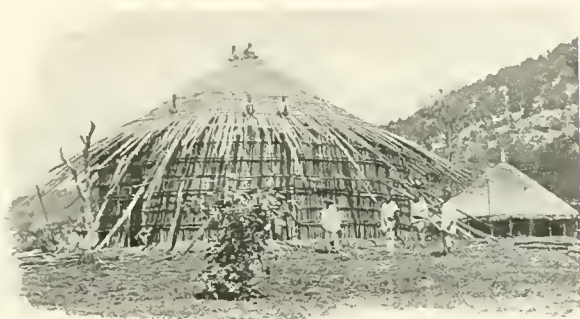
UNE CASE EN CONSTRUCTION AU CHOU
